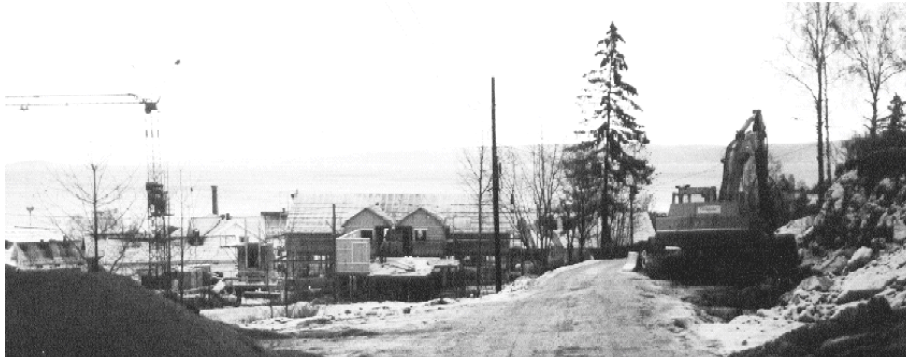
Vollenveien under ombygging i desember 1998, ny gang og sykkelvei anlegges. Eldreboligene i Båtbyggerlia tar form. Foto: R. Fors
